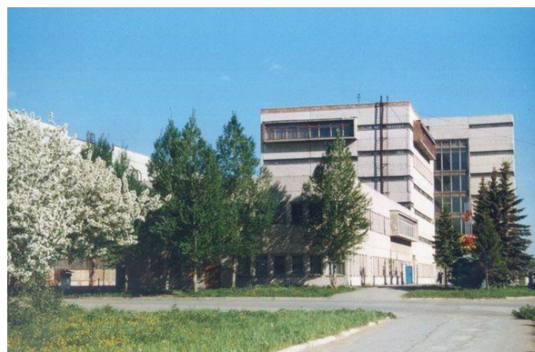
Вид на заводоуправление. Фото 1970 г.
