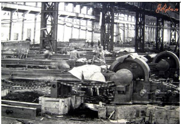
Монтаж оборудования Рисунок 272
