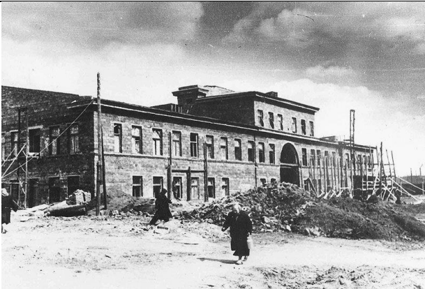
Строительство центральной проходной, зима 1938-1939 гг. Фотография со стороны завода. Рисунок 262
